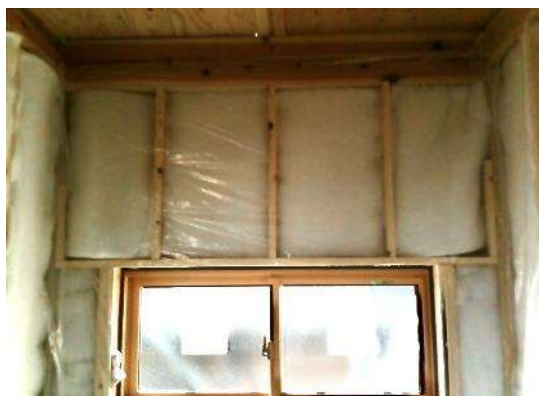
きれいに断熱材が入っているが、断熱材の波うち、隙間が直しきれていない。契約前にぜひどんな工事をする会社か見ておくべきです。
